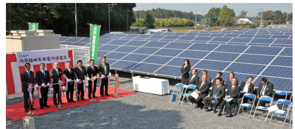
内原地区育苗ハウス内の売電施設
