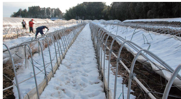
雪害によるハウスの被害
