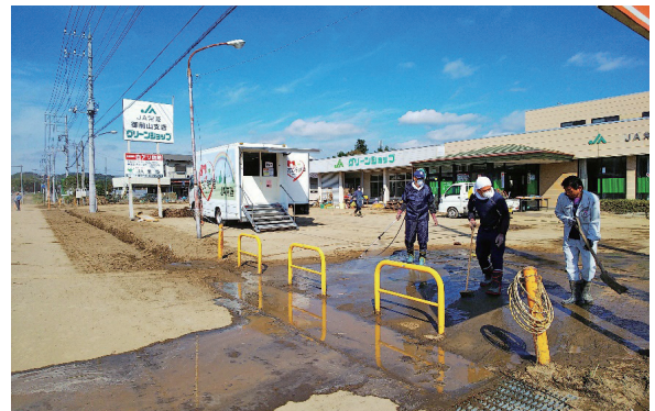
御前山支店の復旧作業と移動金融店舗車
