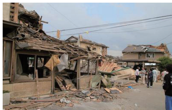
大きな被害を受けた家屋
