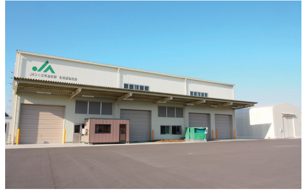
完成した乾燥調製施設
