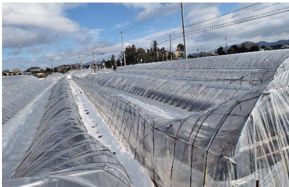
ハウスの被害
