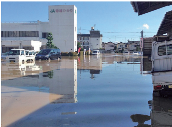
被災した水海道東支店
