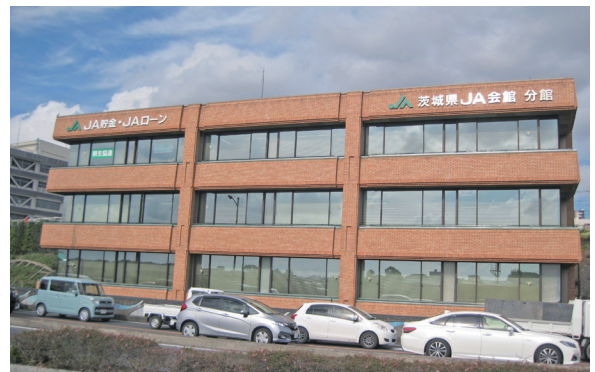
JA会館分館
