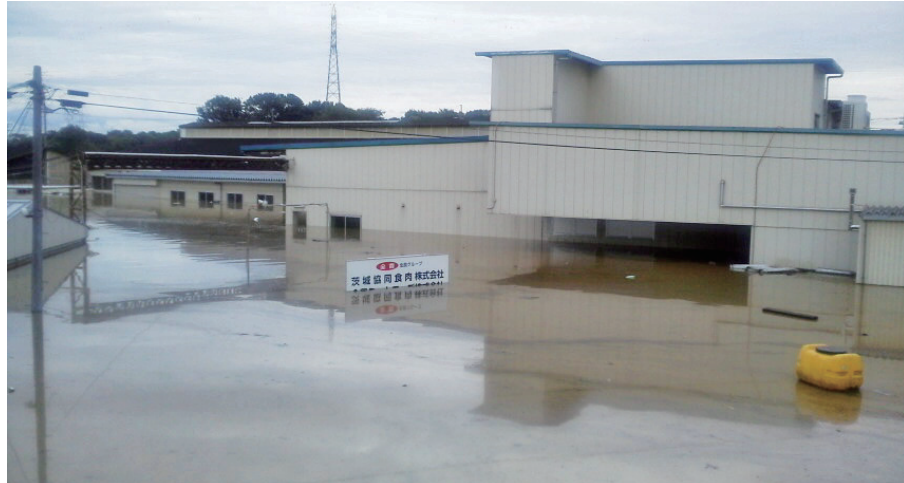
(堤防結果後、事務所内の椅子等を高所に置くなどの作業中に起きた出来事で約30分たらずで約2メートル30センチ増水した。)
